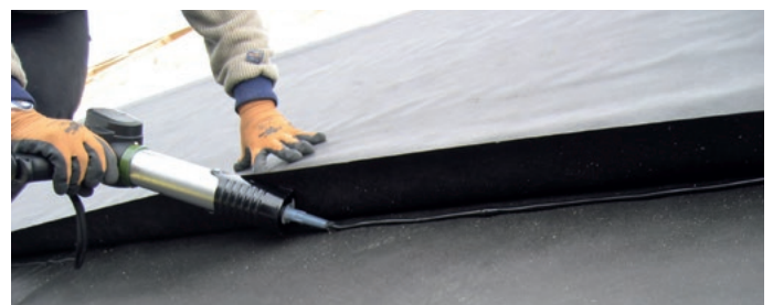
Verkleben der Überlappungen mit an der Bahn integriertem Klebestreifen bzw. Klebstoff
