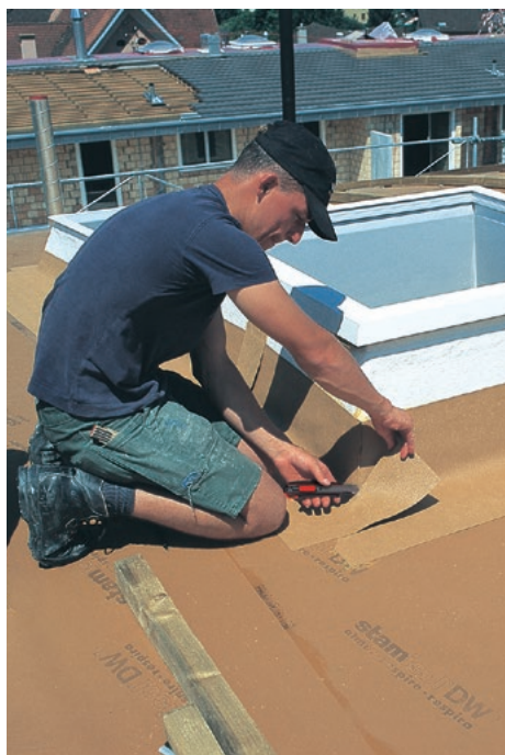
Auf die sorgfältige Ausbildung bzw. Verklebung der Anschlussdetails ist besonders wert zu legen. Hier gilt das Dachziegelprinzip. Für besondere Anschlusspunkte wie Rohrdachdurchführungen oder Dachflächenfenster bietet Würth passgenaues Zubehör.
