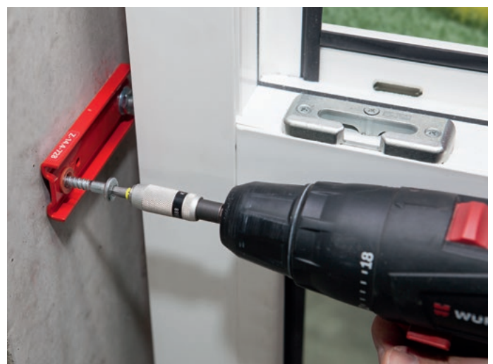
Einbau der Würth Fenstermontageschiene W-ABZ, zugelassen für die absturzsichernde Fensterelementbefestigung an Beton.
